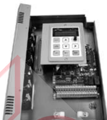
步驟2：完成拆卸面板工作
